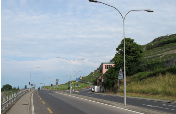
Entrée Ouest de l'agglomération à Corseaux (RC780a), mauvais exemple
