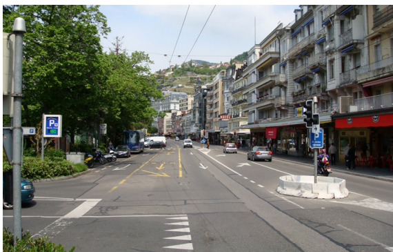
Montreux : Grand-Rue (RC780a), mauvais exemple
