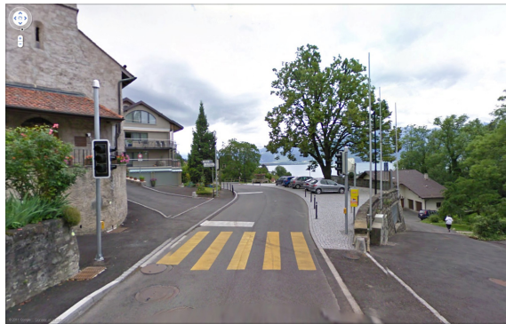
Montreux-Brent : route de Brent, bon exemple Mise en valeur du promontoire avec modération de la circulation, continuité des trottoirs, traversée piétonne lisible.
