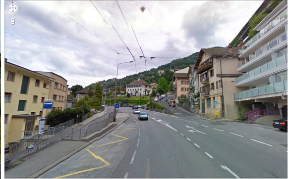
Veytaux : av. de Chillon (RC780a), mauvais exemple
