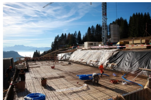
© Blonay - Chantier de l'Espace régional des Pléiades
